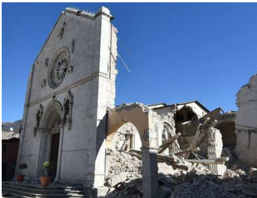
Terremoto 30 ottobre 2016 - Norcia
